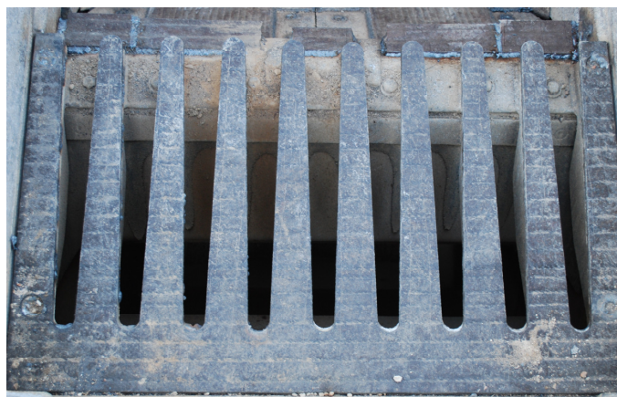
Rošt po opravě karbidovými deskami (oprava trvá jeden den)
